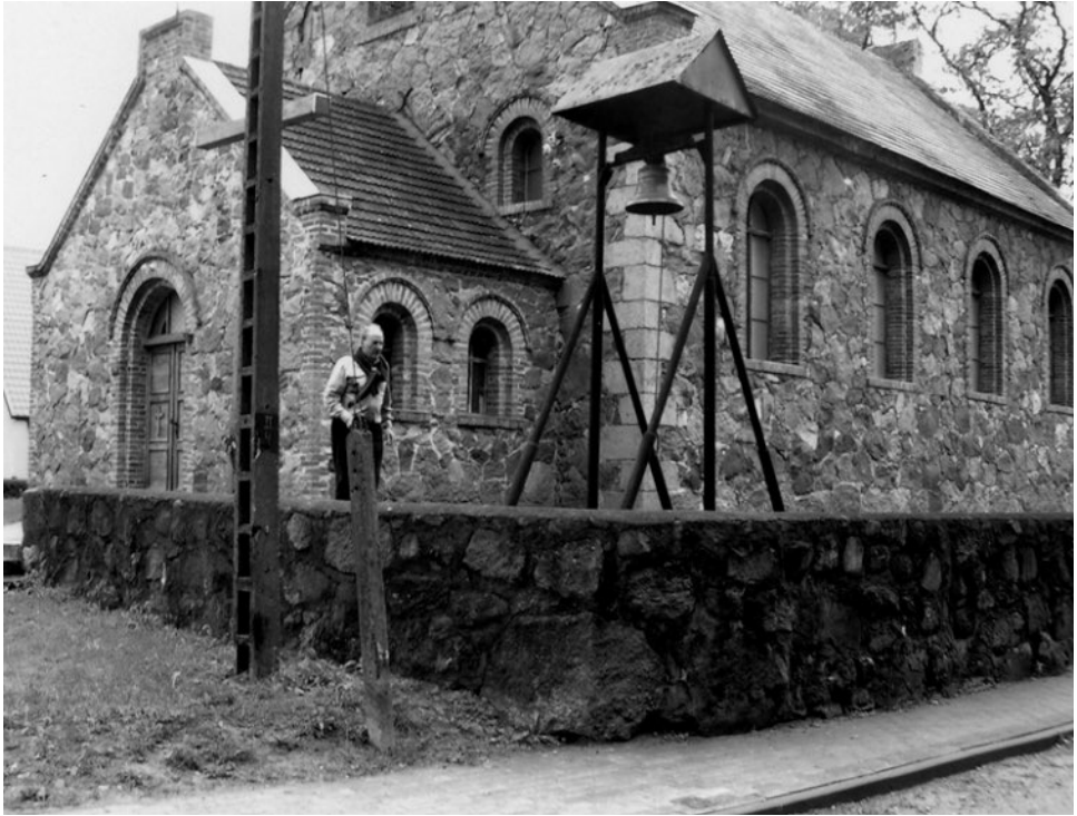
Neue Kirche von Zülkenhagen aus bearbeitetem Feldstein, eingeweiht am 20.12.1864, entnommen: Chronika von Zülkenhagen S. 255
