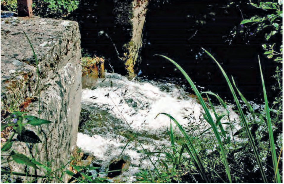
Bild 11: Rest einer Staustufe (1990)
