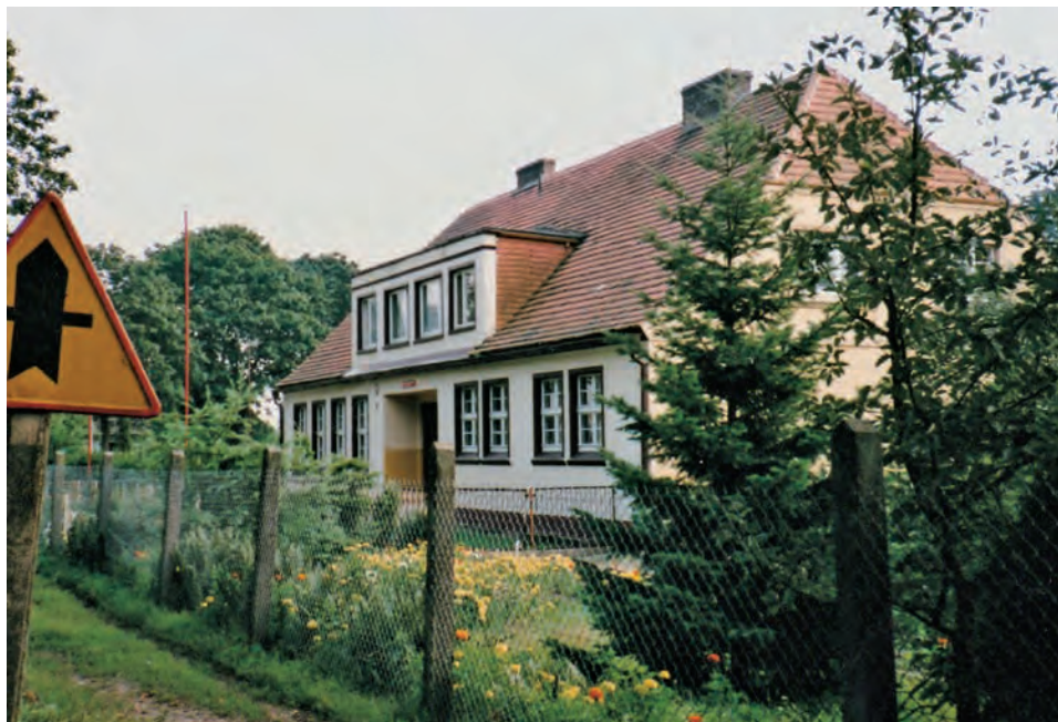
Bild 33: Schule von Drensch, 1990
