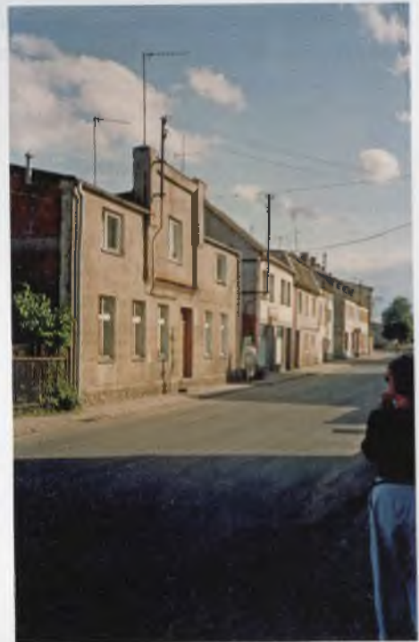
Bild 60: Wohnhaus nach Fluchtabbruch
