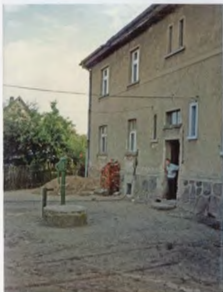
Bild 62: Haus Neustettiner Str. Hofansicht
